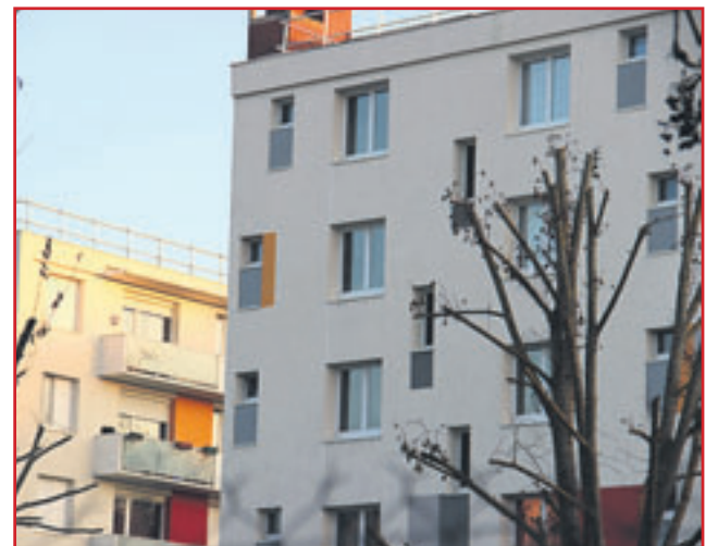
Des logements sociaux rénovés
