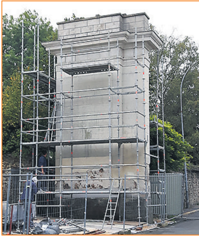
Rénovation d'un pilier de la porte
