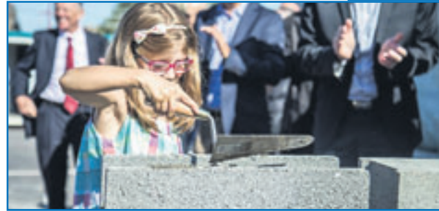
Pose de la première pierre
