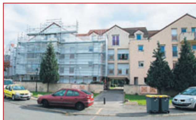
Travaux de rénovation des logements rue du Saule St-Jacques
