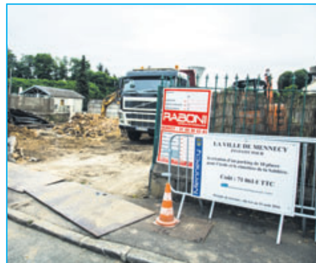
Après la démolition place au parking
