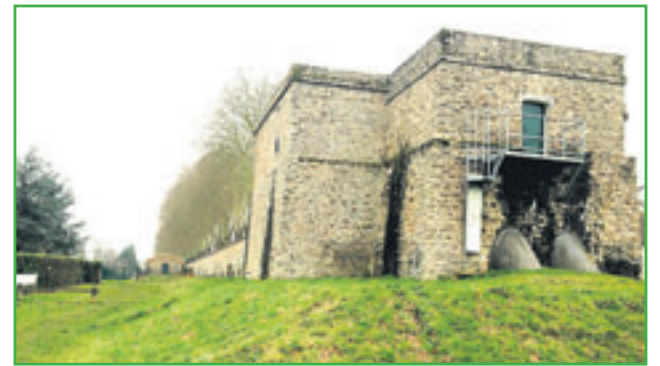
Entrée de la Vanne
